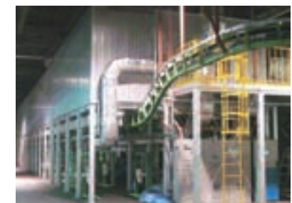
门架涂装生产线
