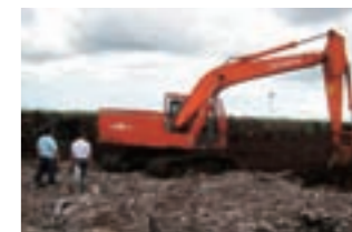
在加里曼丹岛腹地工作的液压挖掘机
