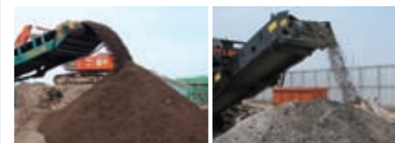
作为县知事特别指定的再生利用施工企业所开展的土砂筛选和瓦砾再生处理
